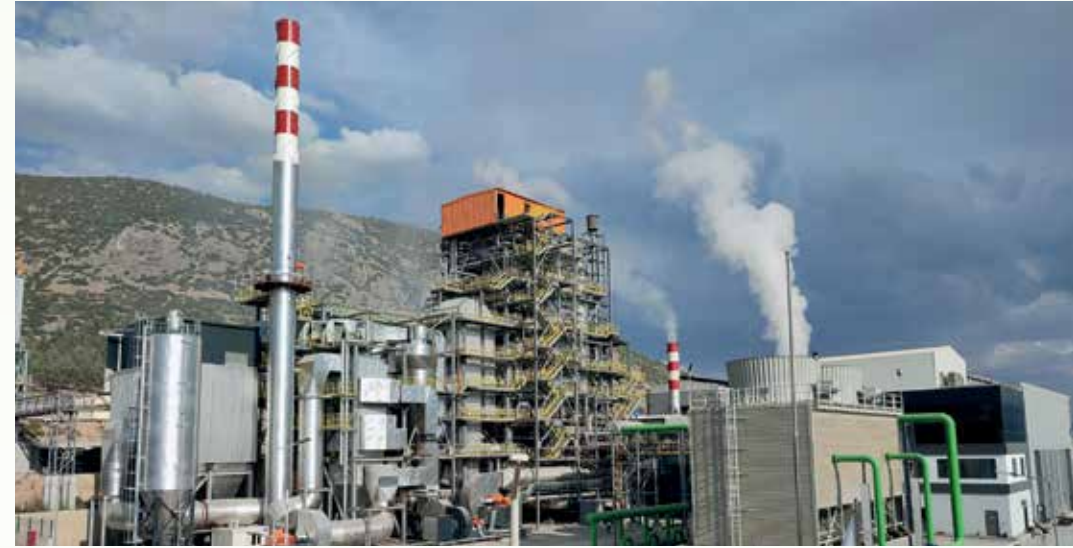
Denizli Biyokütle Elektrik Üretim Santrali
